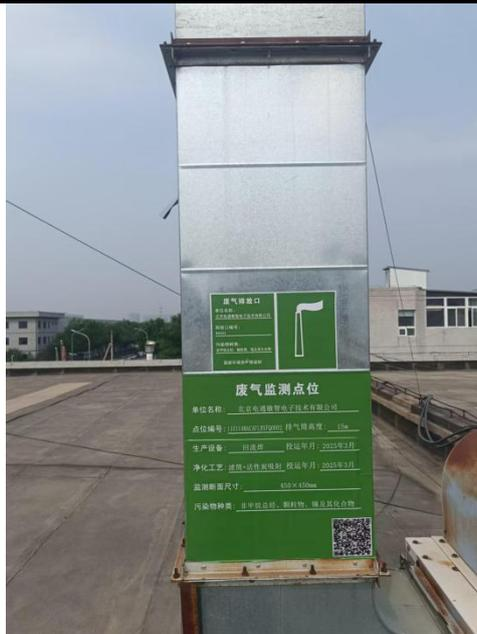
图9 DA002废气监测点位和废气排放口照片
